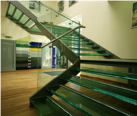
Treppenstufen mit LED hinterleuchtet
