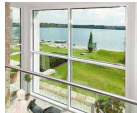
Zu den Festverglasungen wurden Fensterflügel und -türen über Eck angeordnet: Dies ermöglicht eine effektive Querlüftung.
